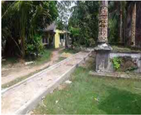
Sebelum Pembuatan jalan setapak di Gedung Hakim
